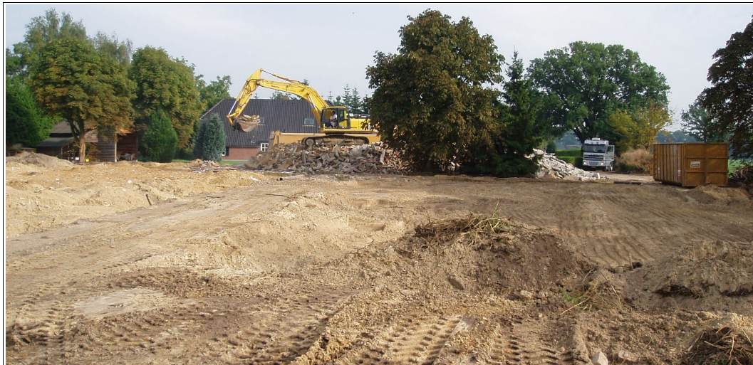
Figuur 2: Laren, Deventerweg 79. Foto van het onderzoeksgebied genomen in noordelijke richting. Tijdens het onderzoek werd het sloopafval van twee voormalige kippenstallen afgevoerd.
