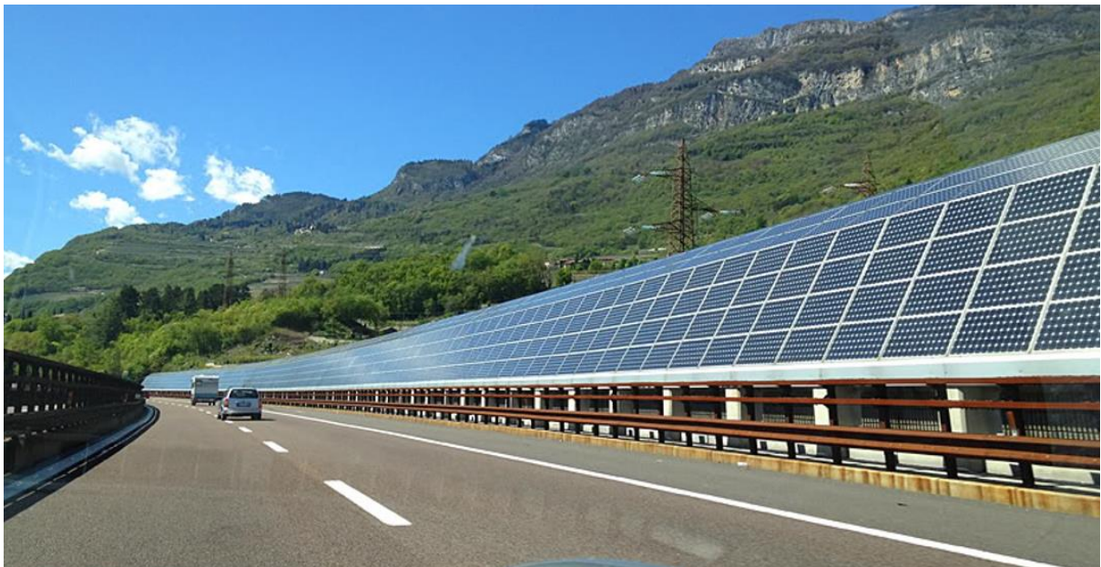
Afbeelding 17: Zonne installatie langs de “Brennerautobahn” in Italië
