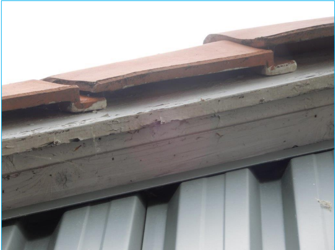
Foto's: Opening tot het dak en de spouw de te amoveren woning.
