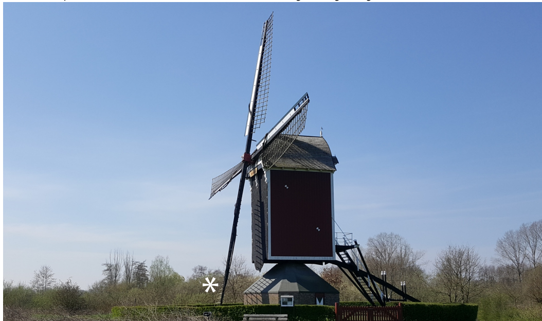
f1.1 Maasmolen april 2016; *bouwlocatie niet zichtbaar door aanwezigheid begroeiing.
