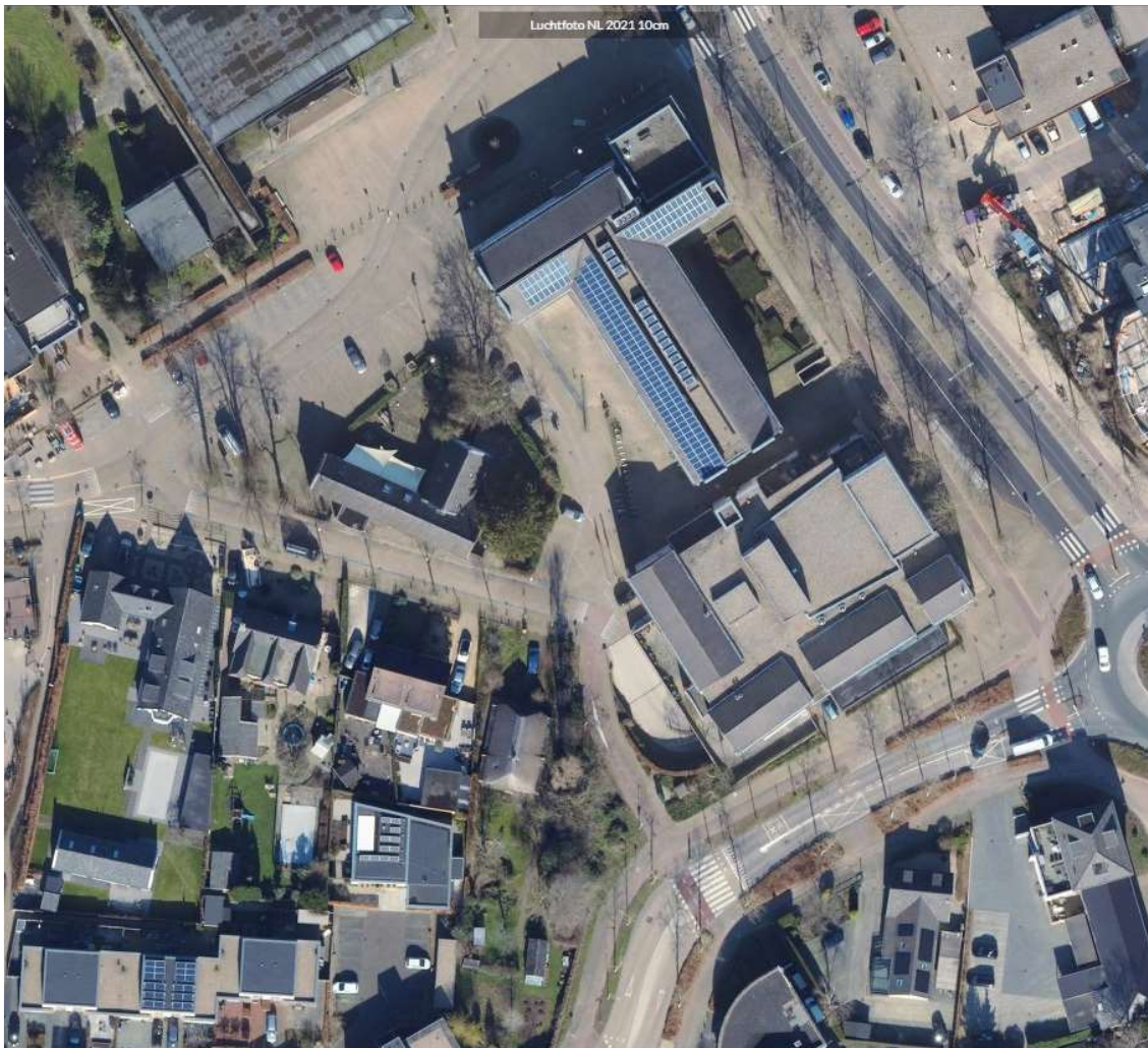
fig. 2 Luchtfoto situatie plangebied 2021 (bron: Street Smart Cyclomedia)
