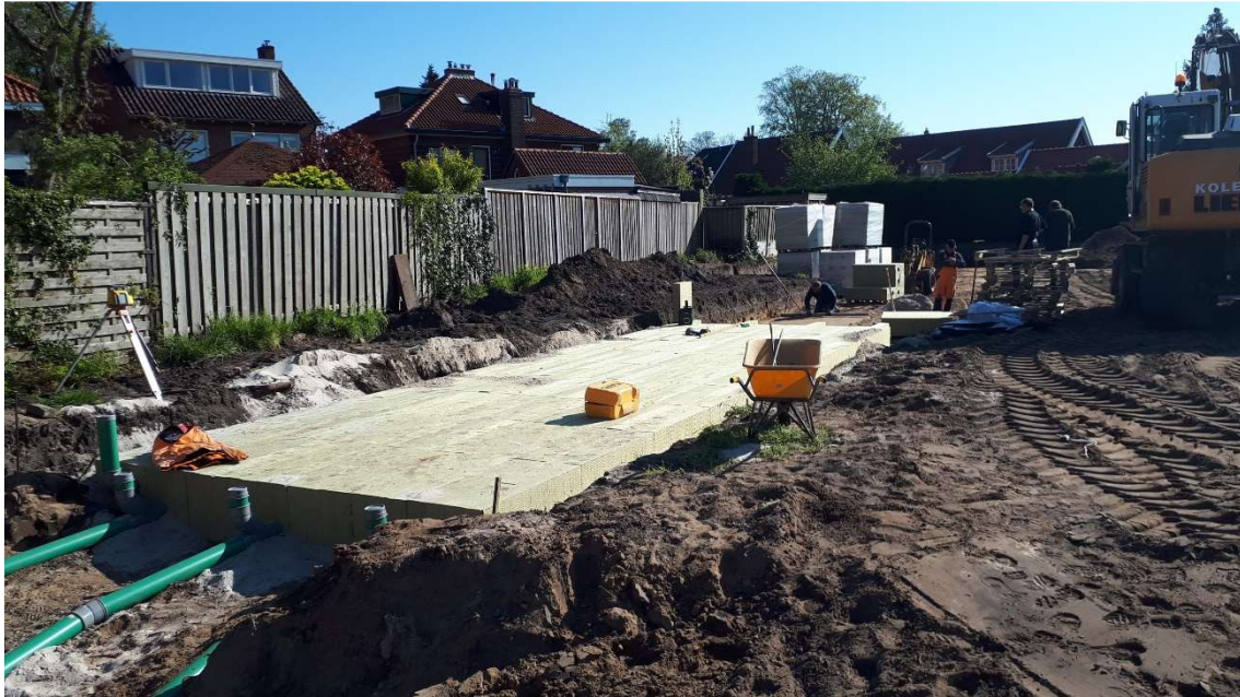
fig. 10 Aanleg Rockflow onder parkeerterrein Borne (bron: foto's projecten Evers adviesburo)
