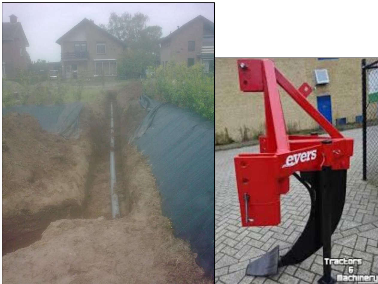
Figuur 4: Foto van de aanleg van een hemelwaterafvoer, vermoedelijk aangelegd in 2015, links. Rechts een voorbeeld van een diepwoeler (bron: opdrachtgever).
