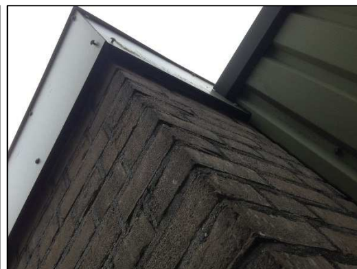
Foto 2. Ruimte achter boeiboord zit dicht met plaat
