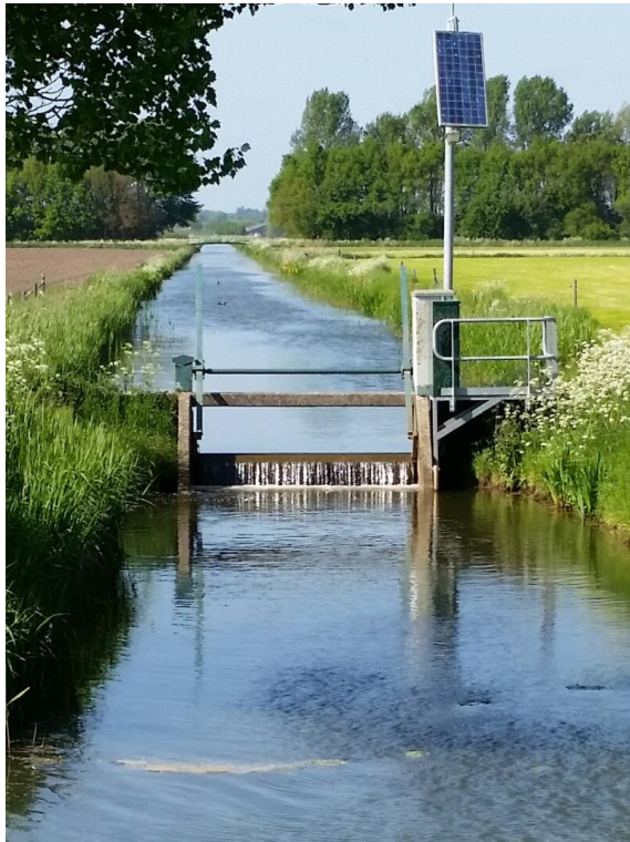
Figuur 6: Voorbeelden verloopstuw-tjes en onderwaterpomp
