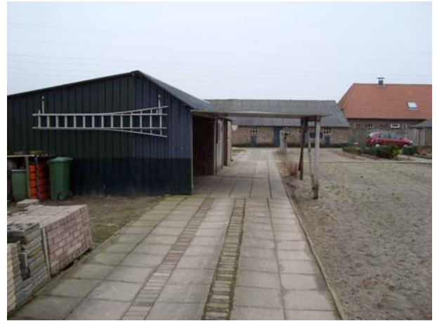
Foto 2. Te slopen kleine schuur.
