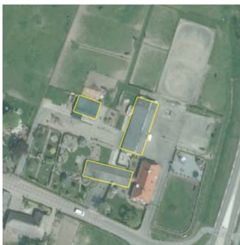
Figuur 2. Luchtfoto plangebied met te slopen gebouwen (geel).
