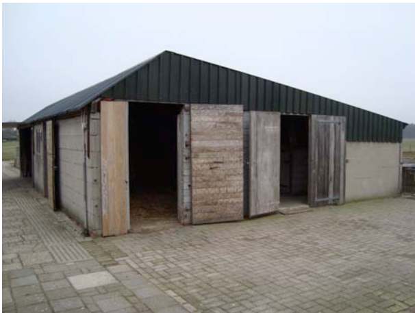
Foto 3. Te slopen kleine schuur.
