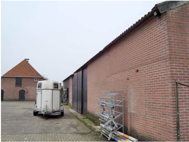
Foto 1. Te slopen grote schuur.
