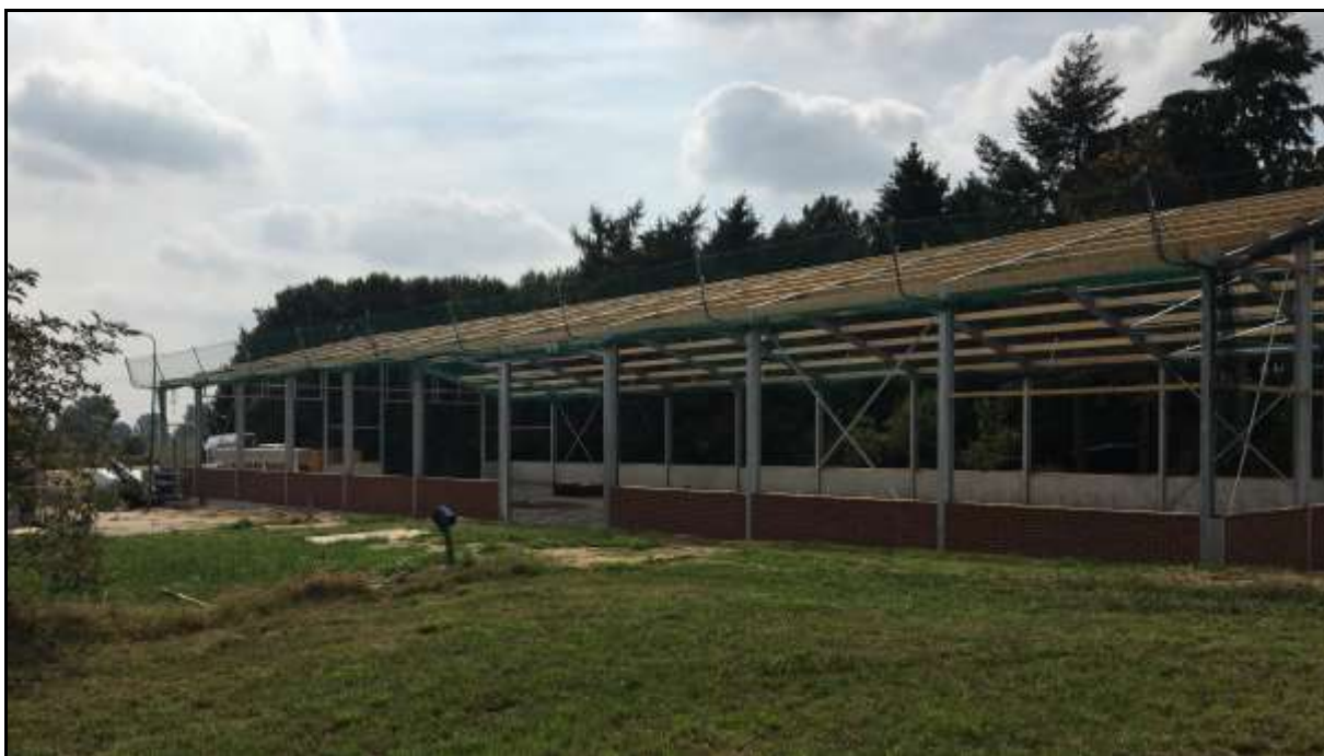
Figuur 2.4: foto loods in aanbouw Valkstraat 19a
