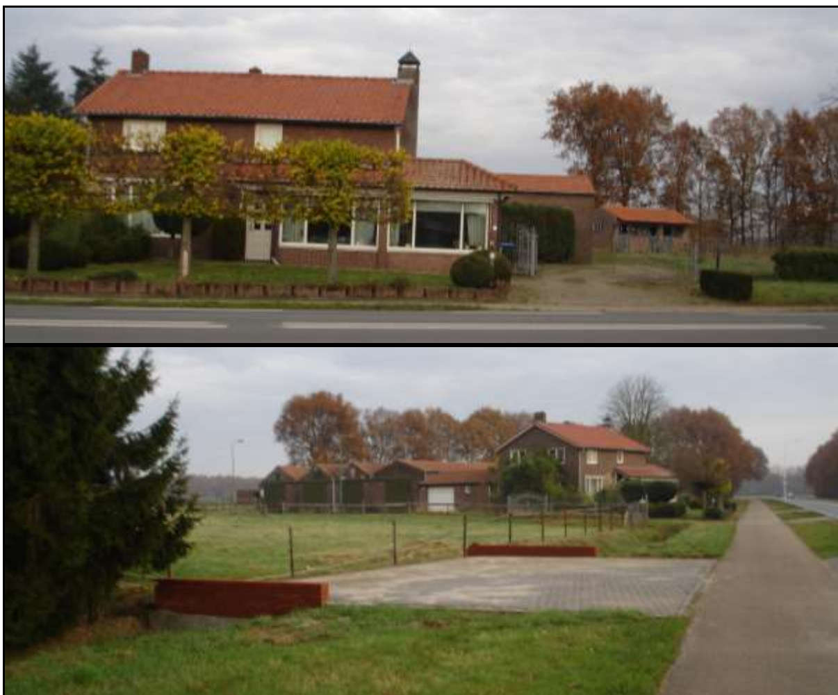
Figuur 2.3: zicht op het plangebied Valkstraat 19 vanaf de straat met onder de uitweg naar Valkstraat 19a.
