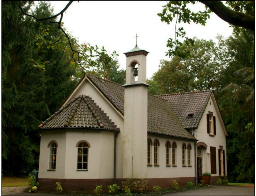
Afbeelding 4: aanzicht noord- en oostgevel
