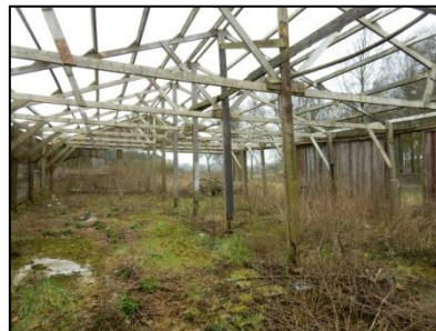
Figuur 4. Binnenzijde geraamte schuur.
