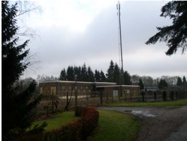
Afbeelding 3-3. Nutsgebouw in zuidelijk deel van het plangebied
