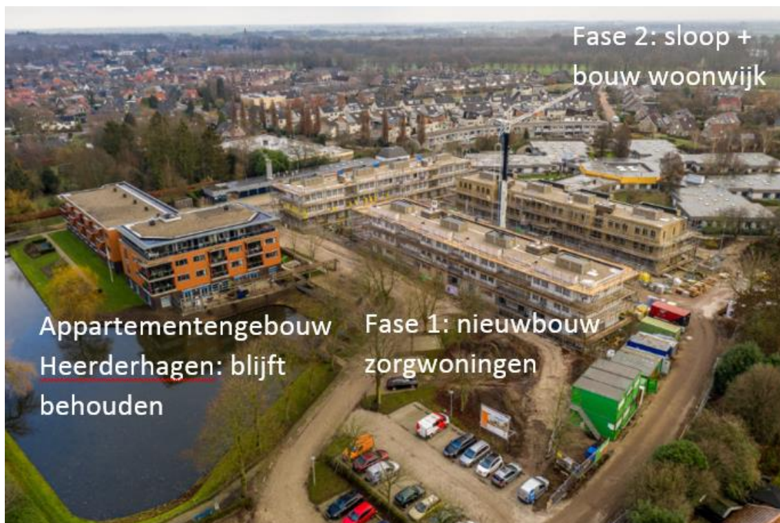
Figuur 1.2 Situatie met fase 1 en op de achtergrond de laagbouw die bij fase 2 behoort (dec 2018, viattence.nl)
