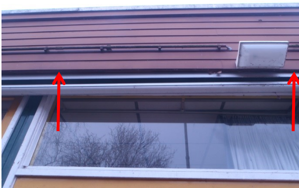
Foto 8: Detail van de betimmering. De zonwering sluit nauwkeurig aan op de muur en de betimmering. De pijlen geven de positie van de ventilatieopeningen aan. Door de verlichting zijn deze twee openingen zeker niet geschikt voor de vleermuis.
