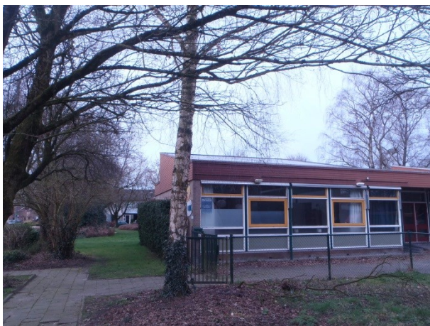
Foto 6: School met grote glazen pui op lage borstwering, hellend dak van bitumen en rondom de betimmering met planken. Oostzijde van de school
