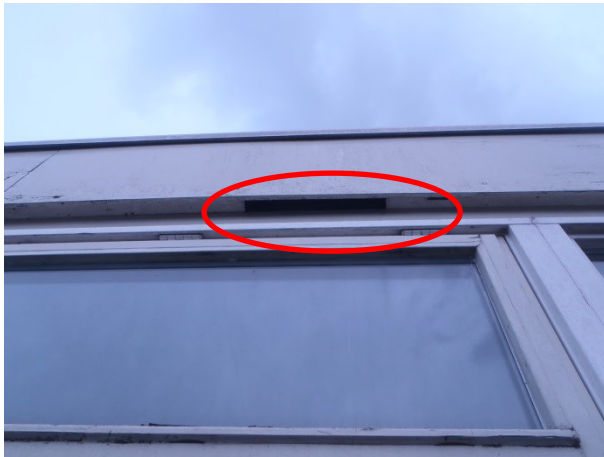
Foto 4: Boeideel met brede ventilatiesleuf.
