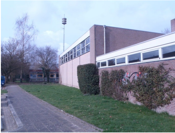
Foto 1: Zuidzijde van gymzaal, de stalenkolommen zijn nog juist als dunne lijnen zichtbaar. Op de voorgrond de uitbouw aan de oostzijde.
