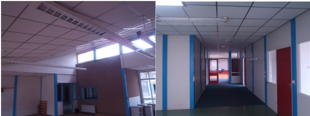
Foto 9: Twee foto's van het interieur. Het systeemplafond volgt het dak van de school.
