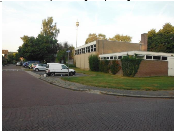
Vanuit oostelijke richting nabij boring 14
