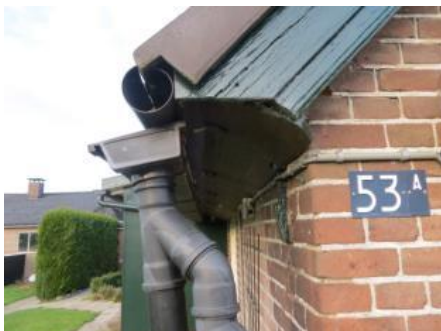
Foto 13 de ruimtes onder de dakpannen zijn volledig afgesloten bij het woonhuis en aansluitende opstal.
