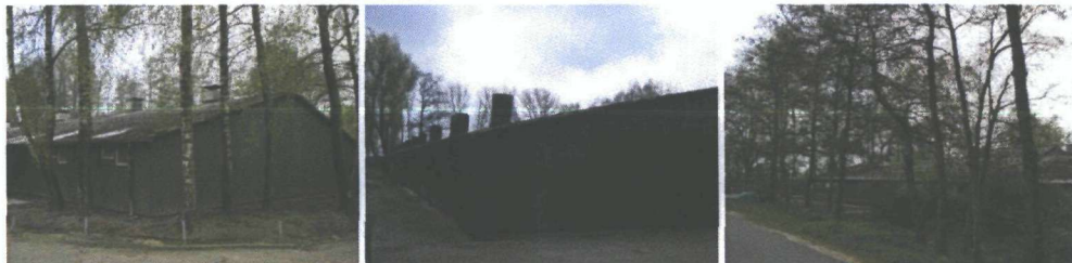
Foto's: Diverse indrukken te slopen varkensstallen.
