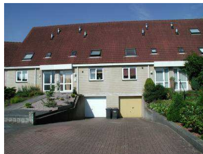
Ondergrondse garages in Walstein.
