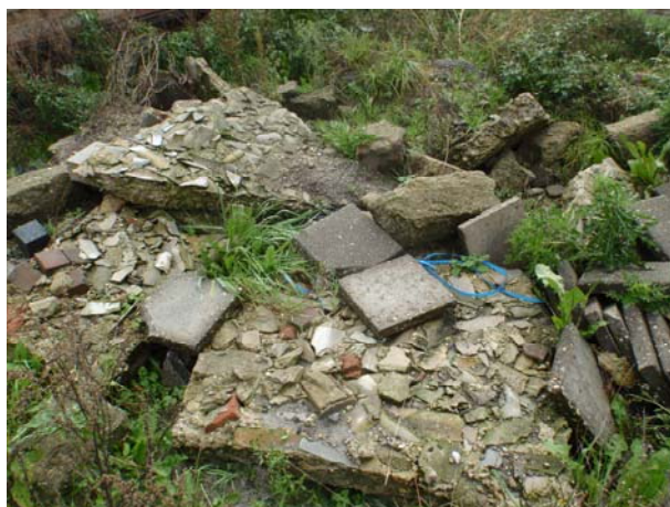
Afbeelding 2: Vloer met asbest verdacht materiaal
