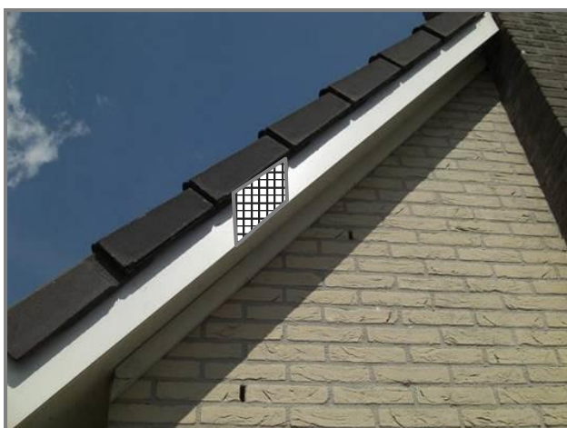
Figuur 7 | Overhangende gevelpannen op glad Trespa met een grip voorziening (fijn gaas of geschilderd ruw zand) voor vleermuizen.
