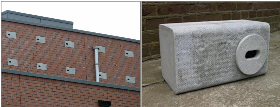
Figuur 13 | IB GZ 01 kasten ingemetseld in de gevel & een losse IB GZ 01 Gierzwaluwkast.
