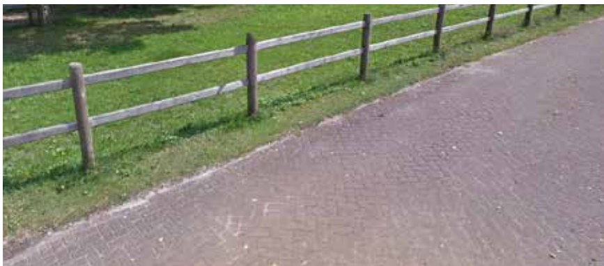
Betonklinkers als verharding voor de toegangsweg
