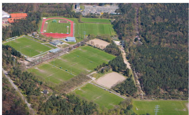
figuur 2 De Strokel met op de achtergrond het transformatorstation
