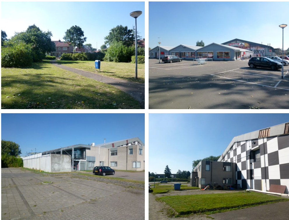
Het park (linksboven), de tijdelijke supermarkt, inclusief parkeergelegenheid, met daarachter de indoor kartbaan (rechtsboven) en zuidwestzijde (voorzijde) van het gebouw (onder).
