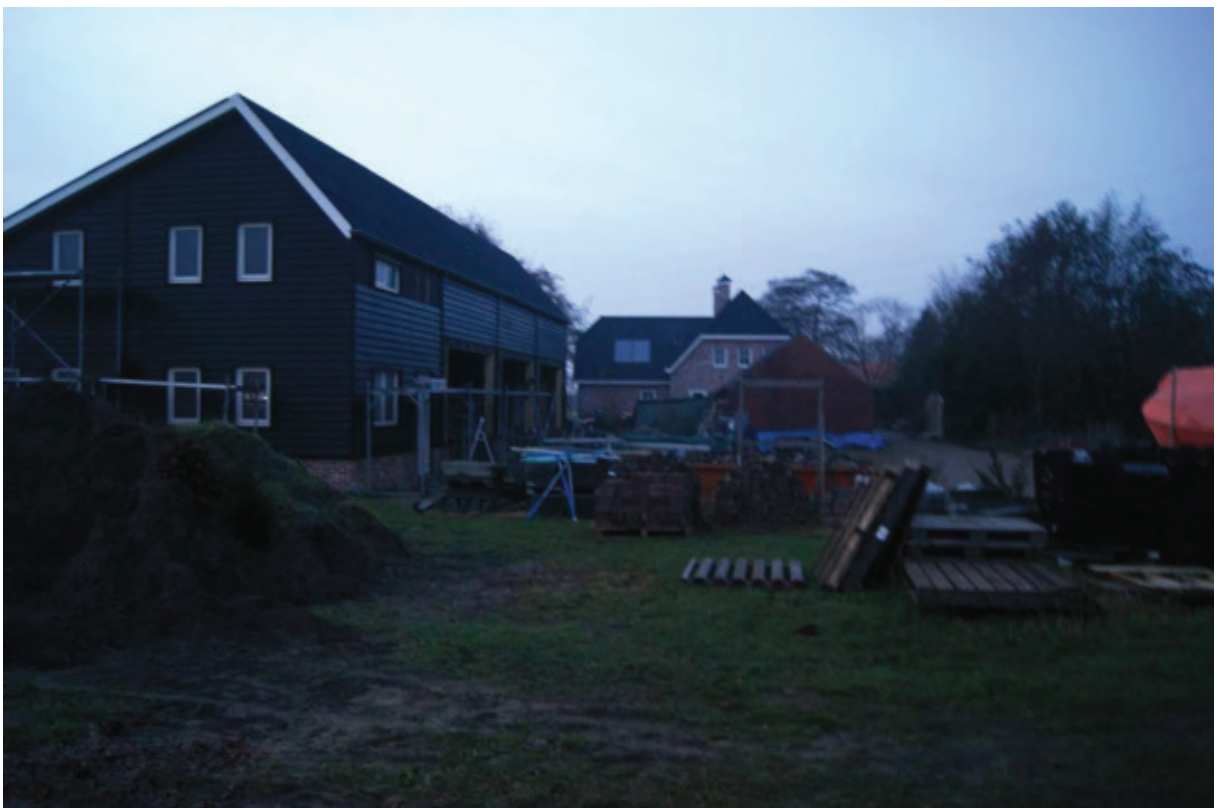
In aanbouw zijnde schuur
