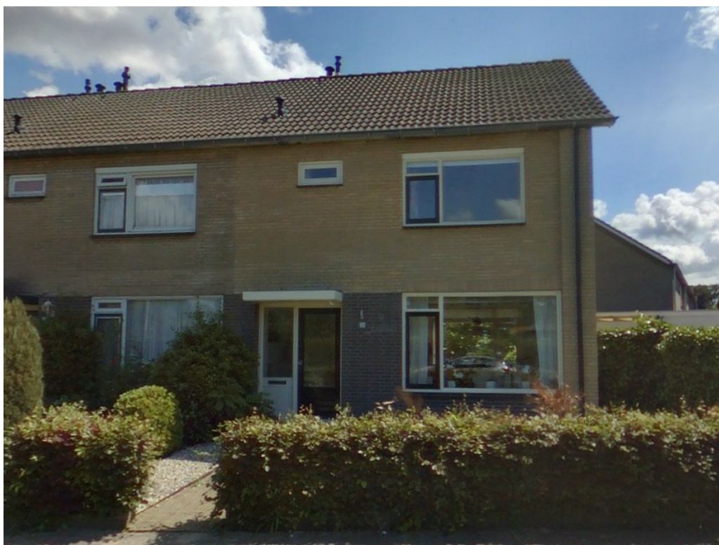
Figuur 5-8 Voorgevel Churchillaan 75, Harderwijk
