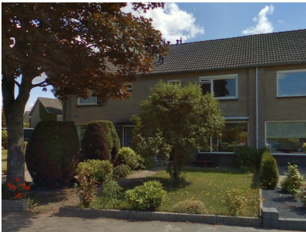
Figuur 5-6 Voorgevel Churchillaan 65, Harderwijk
