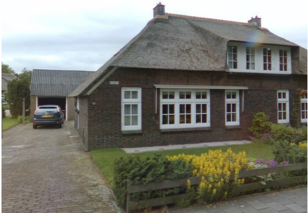
Figuur 5-4 Voorgevel Baanweg 16, Harderwijk
