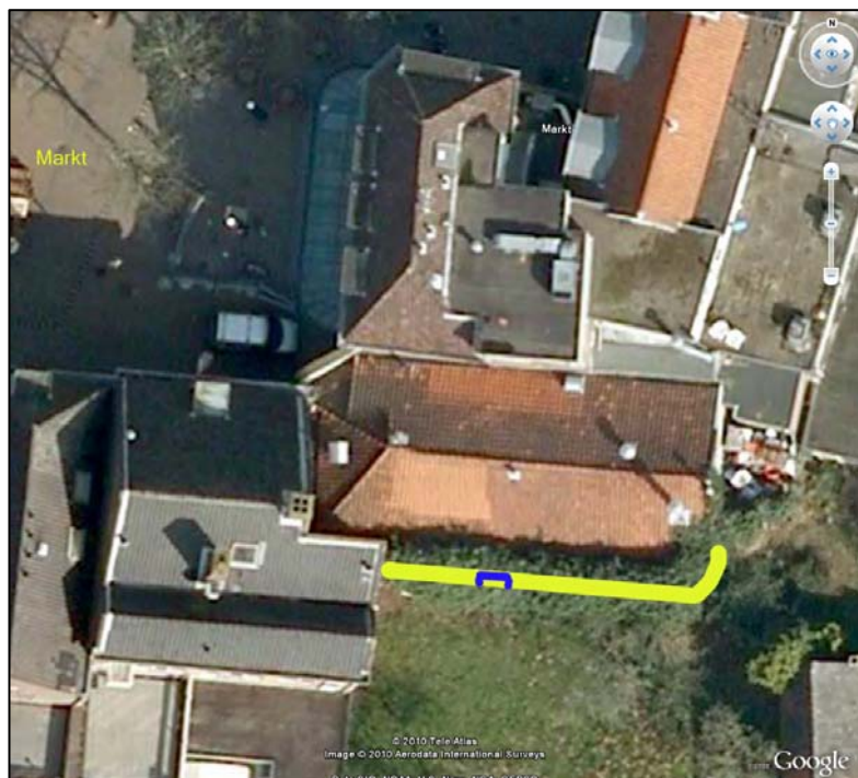
Figuur 1 Kloostermuur (gele lijn) en de opening van de doorgang (blauw). De Klimopvegetatie is duidelijk te onderscheiden. Bron kaartondergrond: Google Earth 2010.
