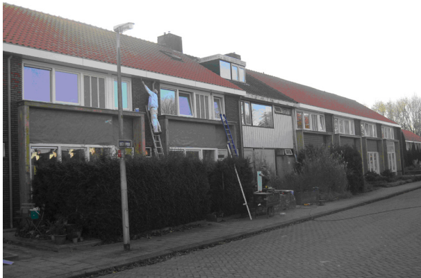
figuur 11 Energiezuinige renovatie in Biddinghuizen
