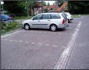
Parkeerplaatsen van rijbaan gescheiden door molgoot
