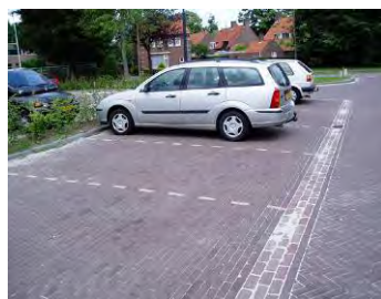
Parkeerplaatsen van rijbaan gescheiden door molgoot
