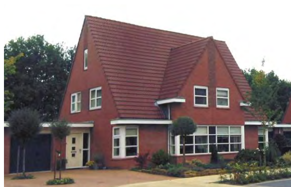
Dorpse sfeer; een lage goot met een hoge kap. Een verbijzondering in de gevel door een vooruitspringend gevelement met een haakse kap.
