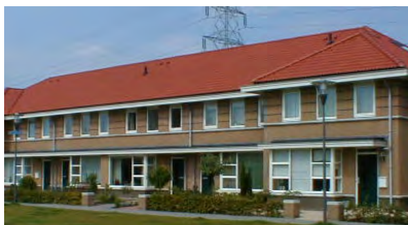
Horizontaal lopende lijnen in de gevel hebben een verlagend effect in het aanzicht.
