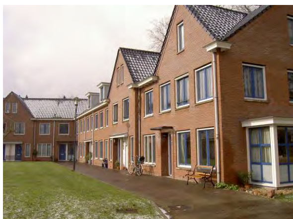
Versterking van de individualiteit door verticale gevelementen; topgevels tegen een langskap en een verspringing in de gevel.
