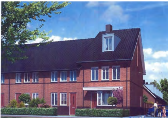
Verbijzondering van de hoekwoning; hoger gesitueerde goot, hogere ramen op de verdieping, erker en luifel op de begane grond.
