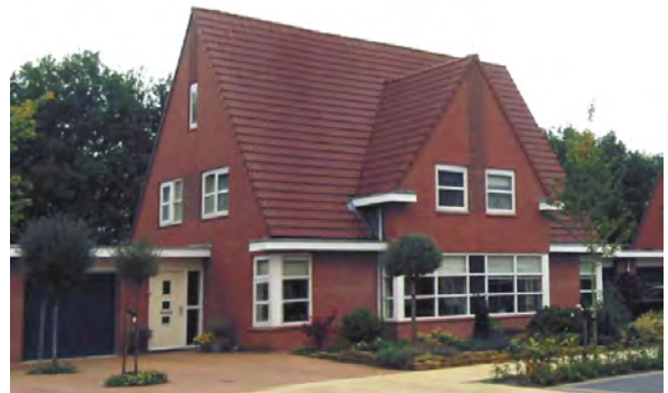
Dorpse sfeer; een lage goot met een hoge kap. Een verbijzondering in de gevel door een vooruitspringend gevelement met een haakse kap.
