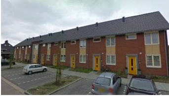
Klompenmaker, geschakelde woningen
