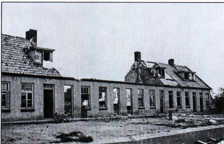
Stekkenberg (nabij onderzoekslocatie 1)
