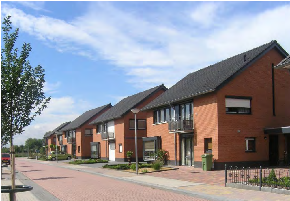
De woningen langs de Bremstraat en de Dries voegen zich in de bestaande rooilijn en kennen een eenvoudige massa- en gevelindeling in combinatie met een langskap. Door middel van het toepassen van eenvoudige bouwkundige details is elke woning individueel herkenbaar. Te denken valt aan erkers, uitbouwen, entrees of balkons
