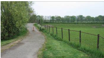
Voet/fietspad in het verlengde van de Waalstraat
