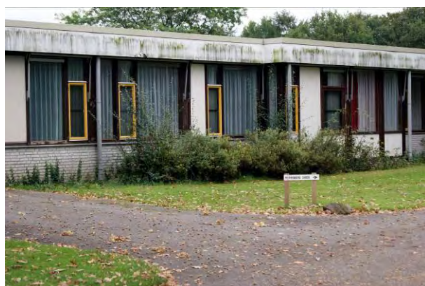
Mogelijke verblijfplaats vleermuizen - daklijsten
