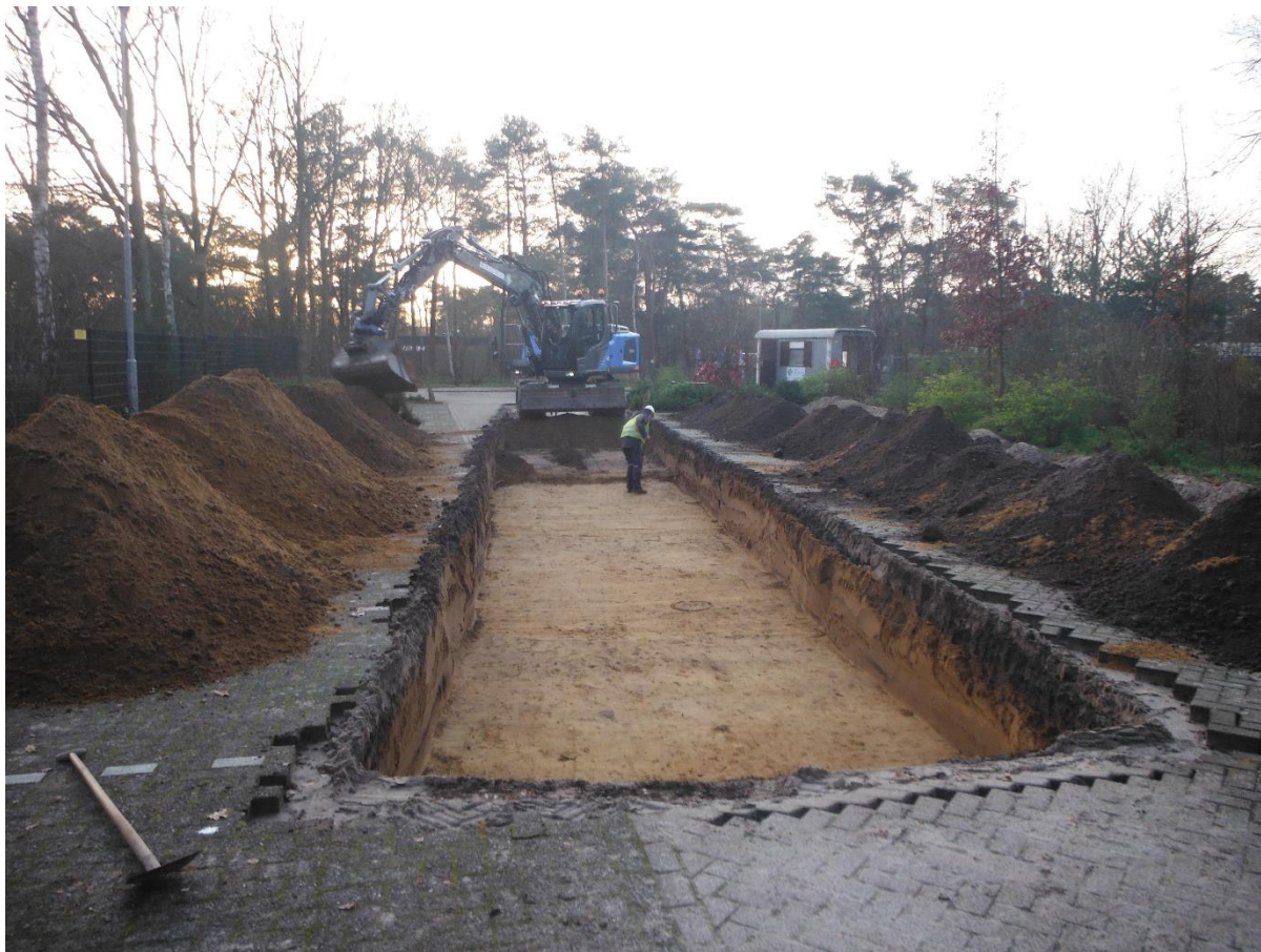
Afbeelding 3 Start aanleg proefsleuven
