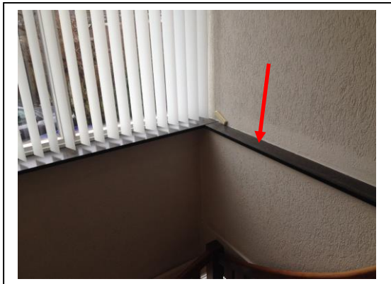
Overzicht foto trappenhuis
