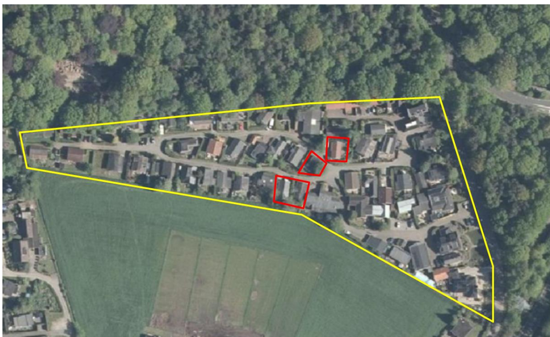
Figuur 1. Bungalowpark Bos en Weide (gele omlijning) met de locaties waar woningen gesloopt worden (rode omlijning) (bron kaartondergrond: www.ruimtelijkeplannen.nl ).
