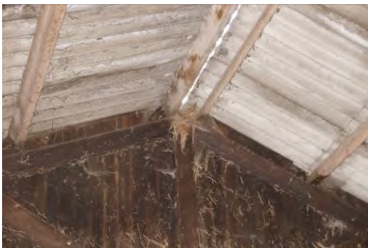
Eventueel te behouden kapschuur
