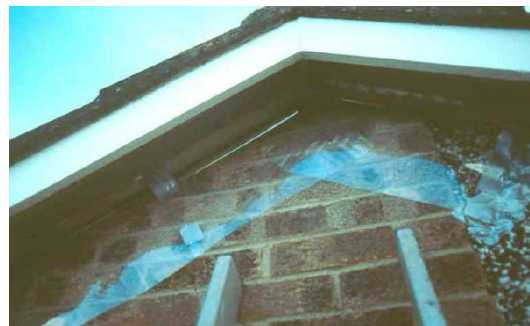
Voorbeeld plastic flappen voor stootvoegen
