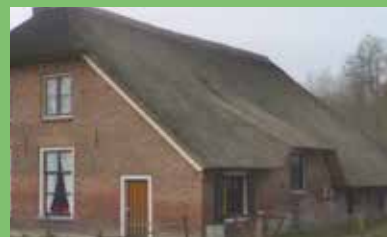
Gevel opgetrokken uit stenen (=gewoon)
