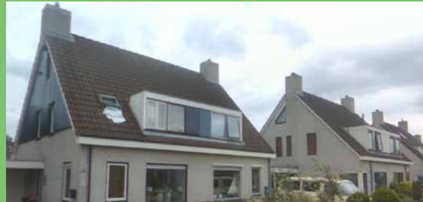
Samenhang tussen de bebouwing in vormgeving, materiaal- en kleurgebruik.
