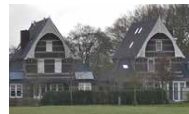
Steil dakvlak met hoge goot (=bijzonder)
