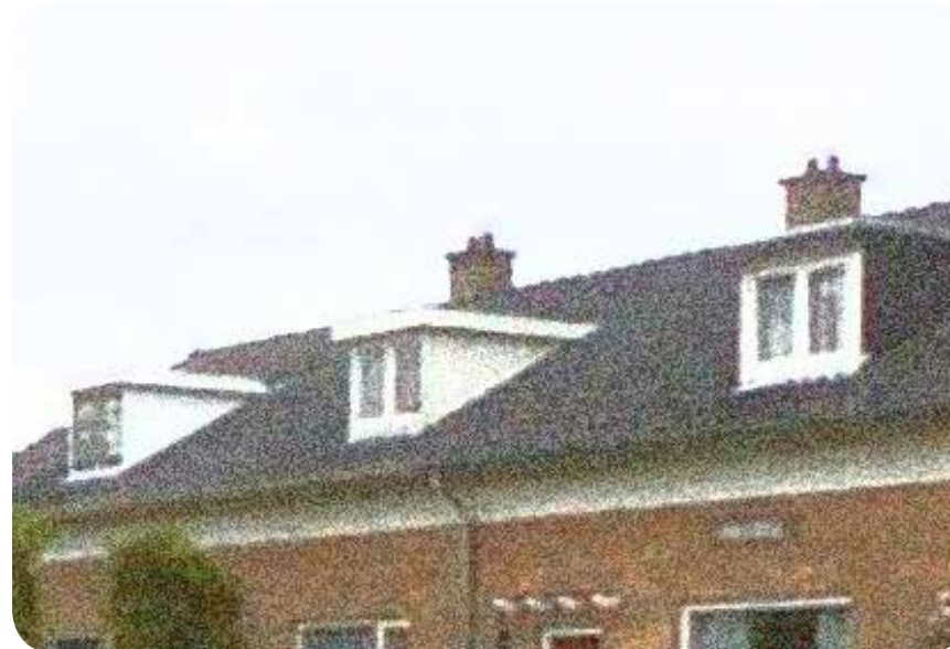
Plaatsing van het dakkapel is afgestemd op andere dakkapellen in hetzelfde dakvlak.
