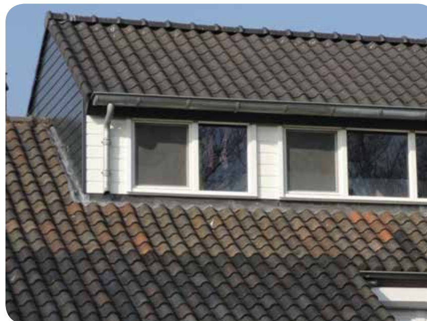
Vormgeving, detaillering en kleurgebruik afgestemd op het hoofdgebouw.
