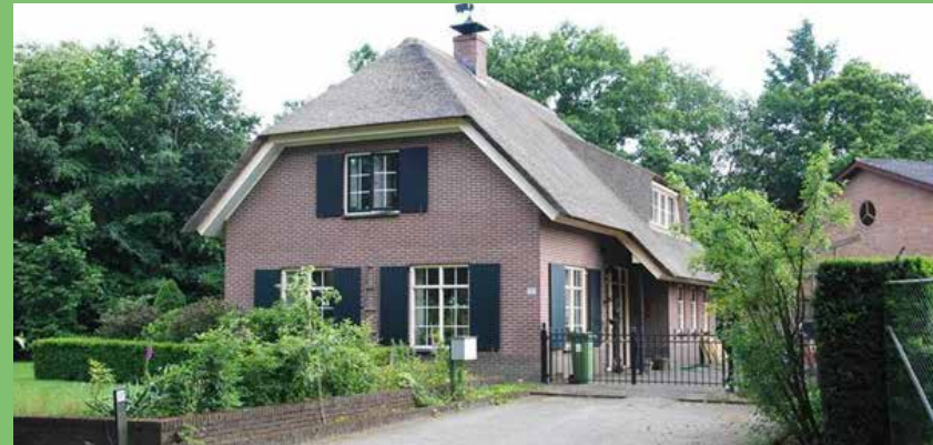
Hoofdgebouw met een kap en (overwegend) lage goothoogte.
