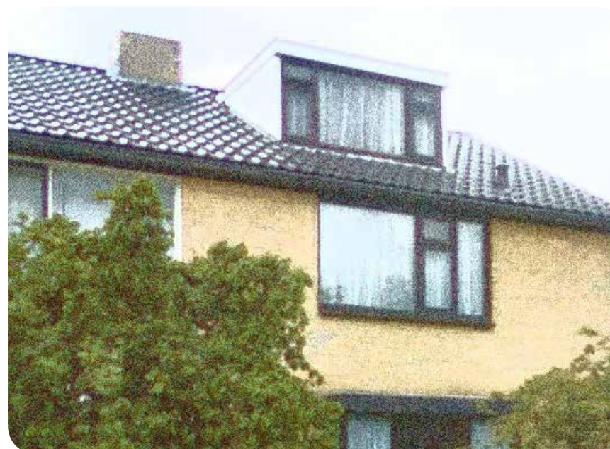
De vormgeving en detaillering van het dakkapel is afgestemd op de architectuur van de woning.
