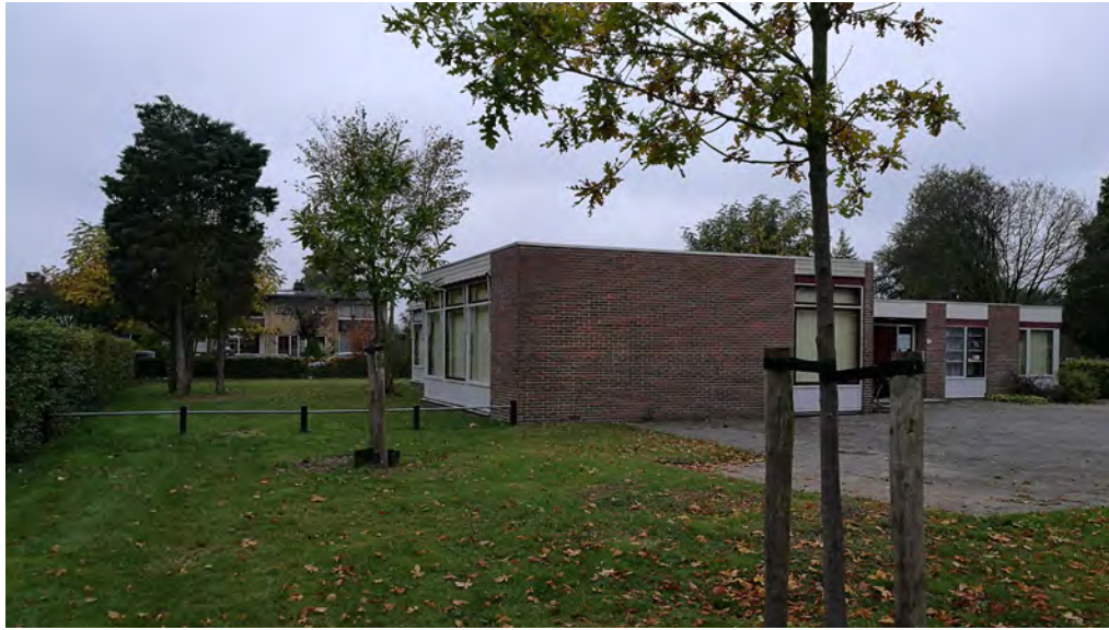
te slopen schoolgebouw
