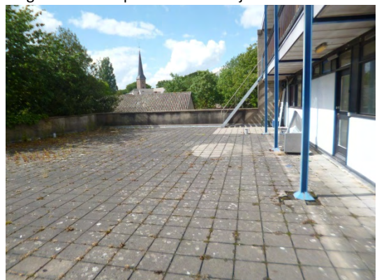
Fig. 5 Dakterras bij bovenwoningen
