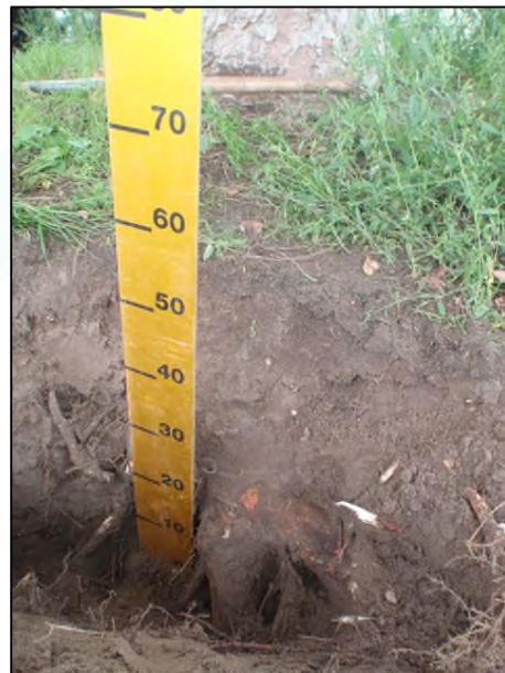
Bij boom 5 is een dikke wortel aangetroffen ter hoogte van het geplande voetpad.
