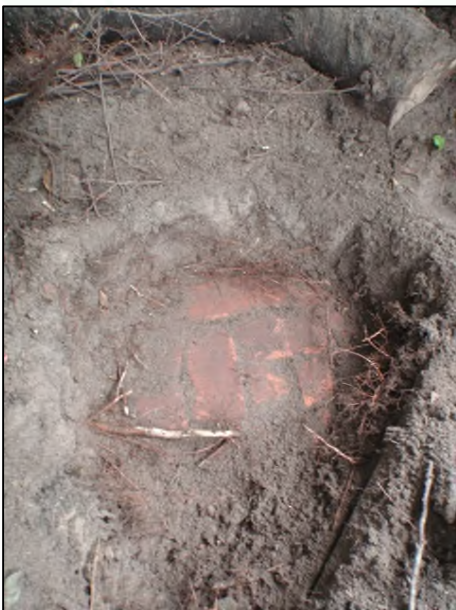
Bij boom 4 is op 20 cm beneden maaiveld een laag klinkers aangetroffen.
