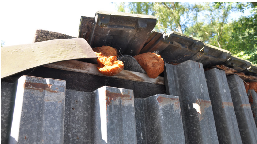
Foto's van met purschuim afgedichte openingen.
