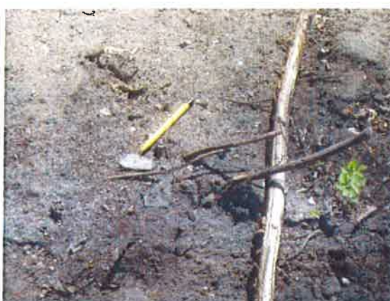
Asbest verdacht materiaal op maaiveld (4)
