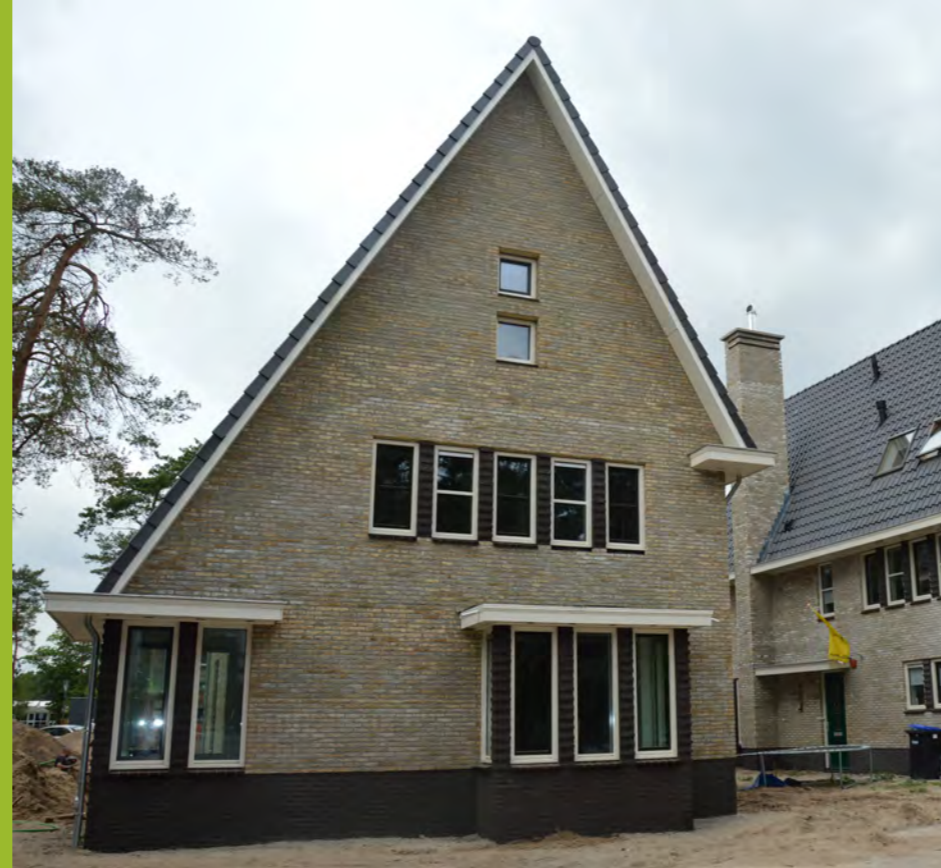
een laag met een kap over twee verdiepingen
