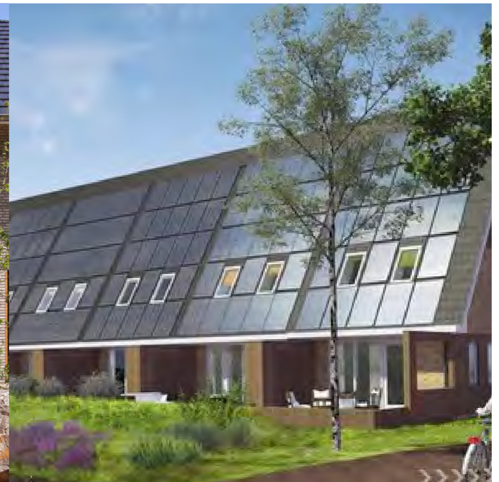
zonnepanelen op de daken ingepast
