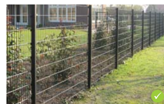
Hekwerk met draadmatten
