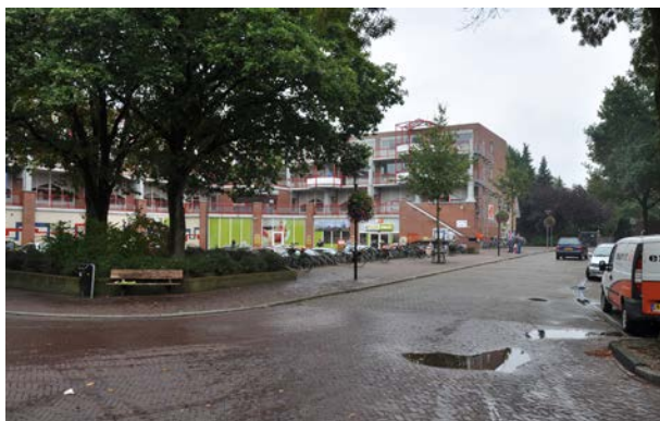
Huidige situatie bebouwing Burgemeester Langmanstraat
